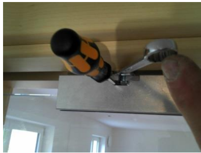
13. Klemmbacken einhängen und richtige höhe einstellen
