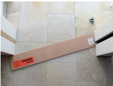
6. Das Montagebrett auf den Boden legen, dieses dient als Montage Hilfe
