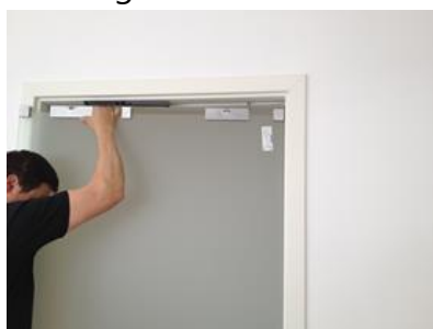
10. Vorderen Klemmbacken mit oder ohne Softclose montieren
