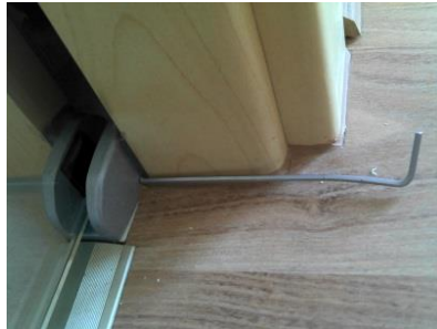
2. Bodenführung mittig Zarge montieren
