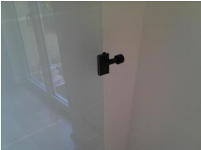
1. Hinteren Endanschlag auf das Glastürblatt mittig montieren
