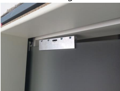
9. ...den großen hinteren Klemmbacken auf das Glastürblatt montieren
