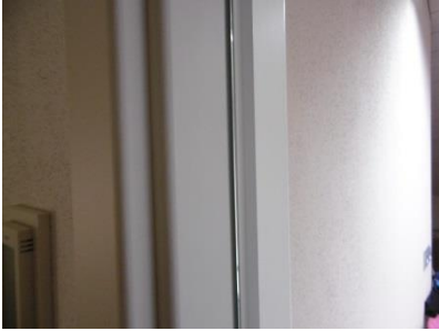
15. Das Glastürblatt vorne bündig mit Zarge einstellen
