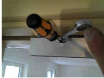
16. Wenn diese passt können die Kontermuttern angezogen werden
