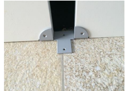
2a. Falls der Adapter verwendet wird, kann die Bodenführung am Ende montiert werden (Zubehör)
